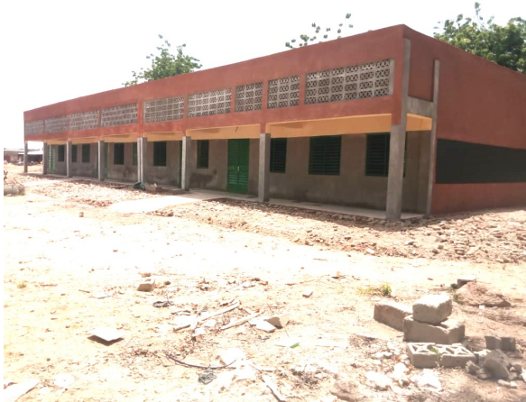
La rénovation de l'école de BEKA-A terminée.
